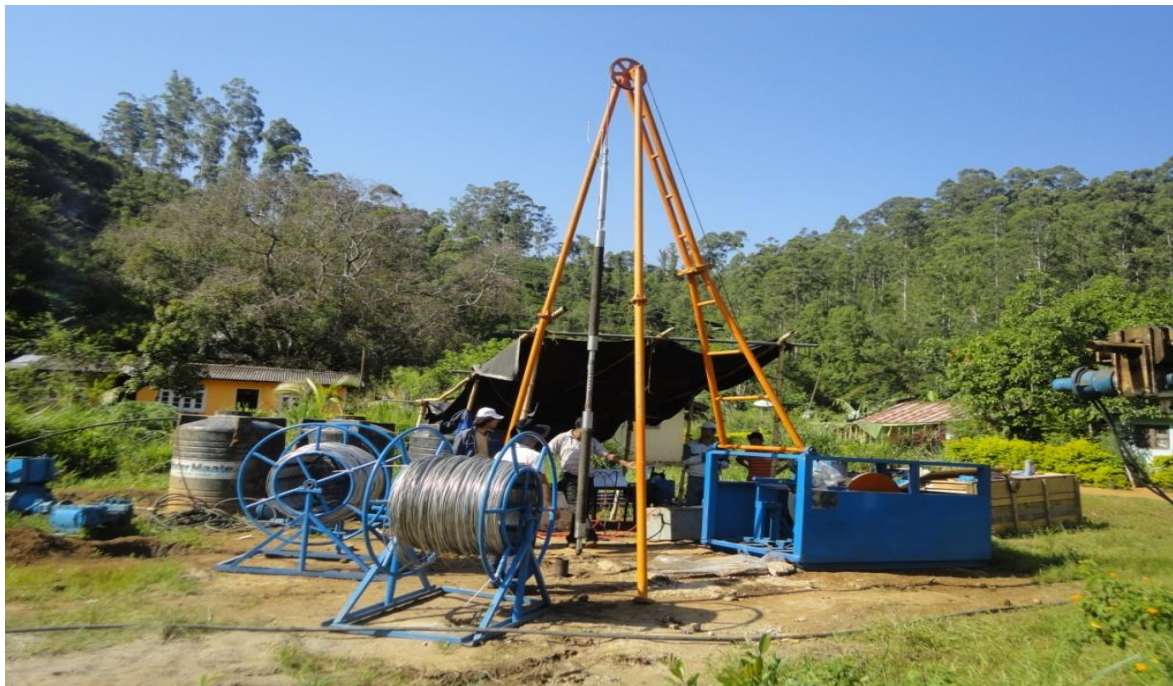
انجام آزمایش شکست هیدرولیکی - پروژه اوما-اویا کشور سریلانکا تا عمق ۸۵۰ متر
