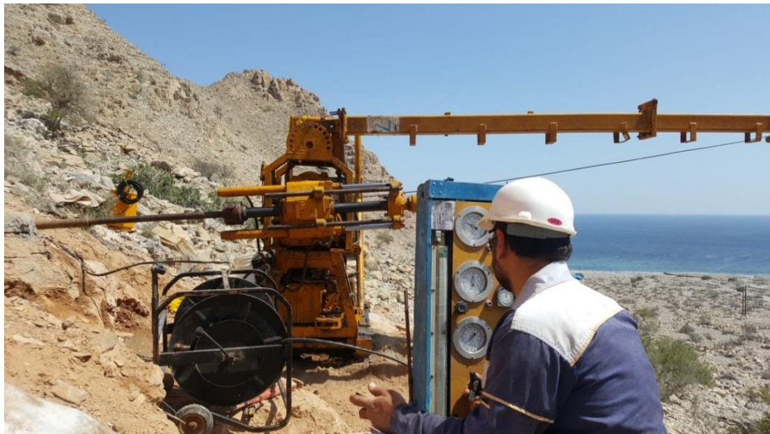
انجام آزمایش پرسیومتری - پروژه مطالعات ژئوتکنیک کشور عمان
